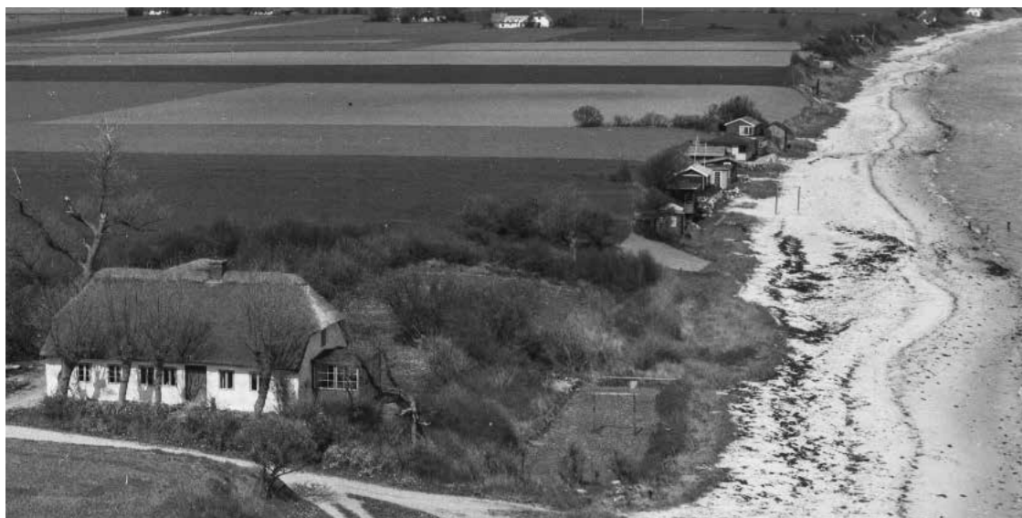
Det gamle toldsted ved Toldvejen i Hølken, 1956. I baggrunden er de små sommerhuse, Havhusene, begyndt at skyde op.
